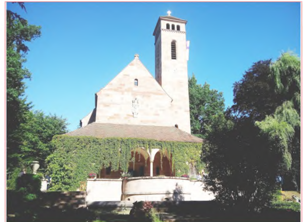
Die Philippuskirche Rummelsberg wurde in den Jahren 1924 – 1927 gebaut. Die „Zöglinge“ der Erziehungsanstalt und die Jungbrüder leisteten den größten Teil des Kirchbaus. Rund 12.000 Sandsteinquader wurden im eigenen Steinbruch von Hand gebrochen, 210 Bäume gefällt.
