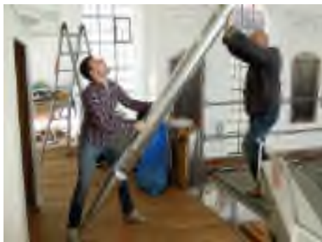
Beim Einbau der großen Prospekt Pfeifen
