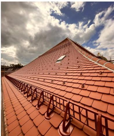
gebessert und eine neue Lattung aufgenagelt war, wurde das Dach mit speziell für Kirchendächer geeigneten Dachziegeln eingedeckt und danach der Kran entfernt.
